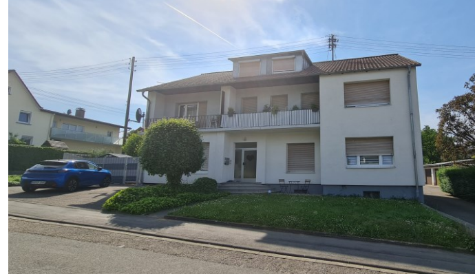
Baujahr 1958 Zielsanierung: EH 55 EE (Wärmepumpe)
