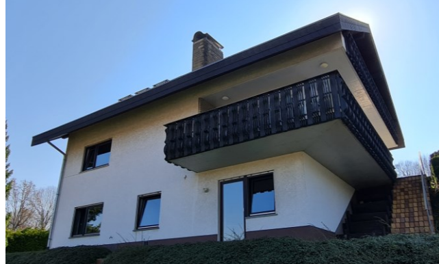
Baujahr 1979 Zielsanierung: EH 70 EE (Wärmepumpe)
