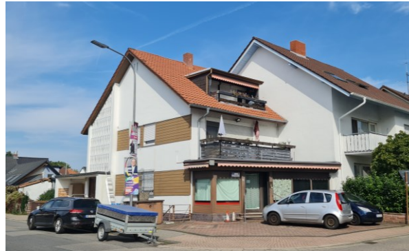
Baujahr 1965, Anbau 1989 Zielsanierung: EH 70 EE (Wärmepumpe)
