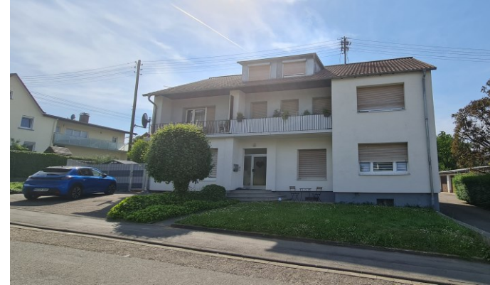
Baujahr 1958 Zielsanierung: EH 55 EE (Wärmepumpe)
