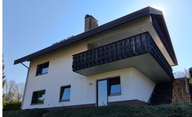
Baujahr 1979 Zielsanierung: EH 70 EE (Wärmepumpe)
