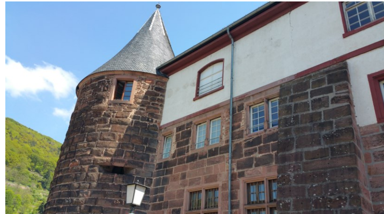
energetische Sanierung Marstallhof, Verwaltung, Heidelberg Auftragsvolumen: 0,25 Mio. € Bauzeit: 2015-2018
