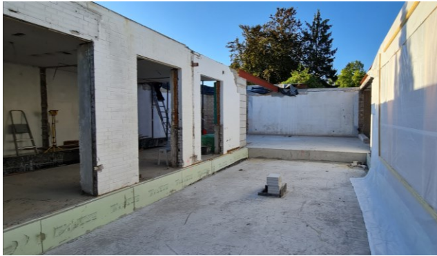
Baujahr 1966 Zielsanierung: EH 85 EE (Wärmepumpe)
